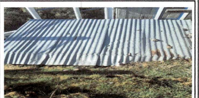
Foto 6: Sustitución de techo de baño de lamina por lamina troquelada.
