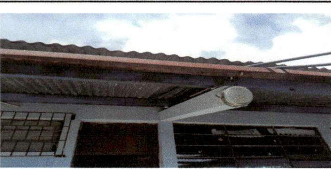
Foto 5: sustitución de canales y bajadas de agua.
