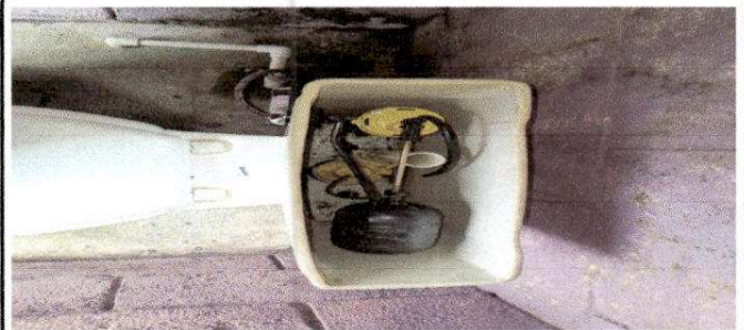
Foto 8: sustitución accesorio, inodoro, contra llave, tubo de abasto, y tanque.
