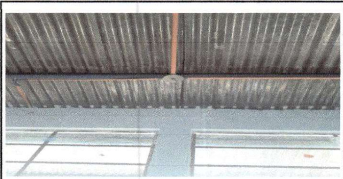
Foto 10: Sustrucción de lamparas, plafoneras tomacorrientes y apagadores.
