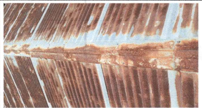
Foto 2: Sustitución de capotes de lamina por lamina troquelada
